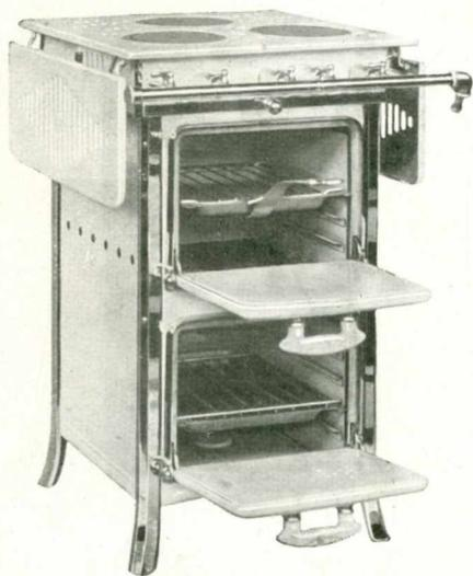
NOTA. — Les réchaud et cuisinières ci-dessus sont munis de 3 brûleurs pipes doubles. Les fours possèdent des brûleurs reversibles et sont complètement enveloppés par les gaz chauds. Le robinet correspondant au brûleur du four est muni d'un dispositif de sécurité empêchant toute fausse manœuvre.
